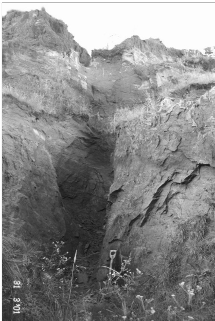
Figura 5 - Fendas e dutos
