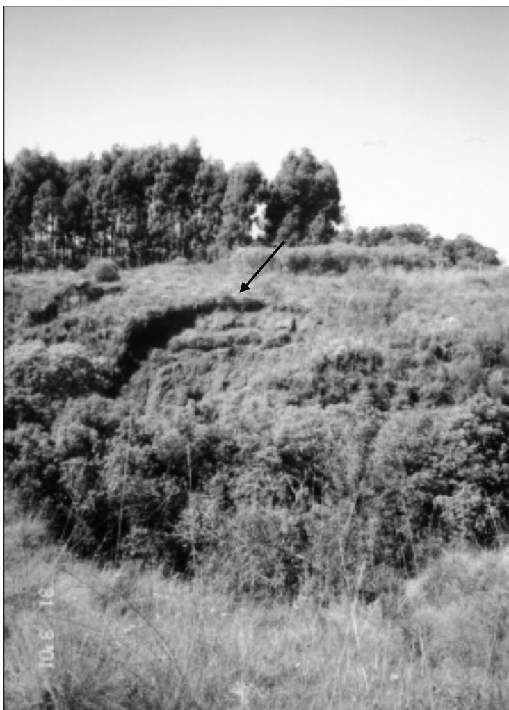
Figura 3 – Solapamento ao longo de fendas de tração
