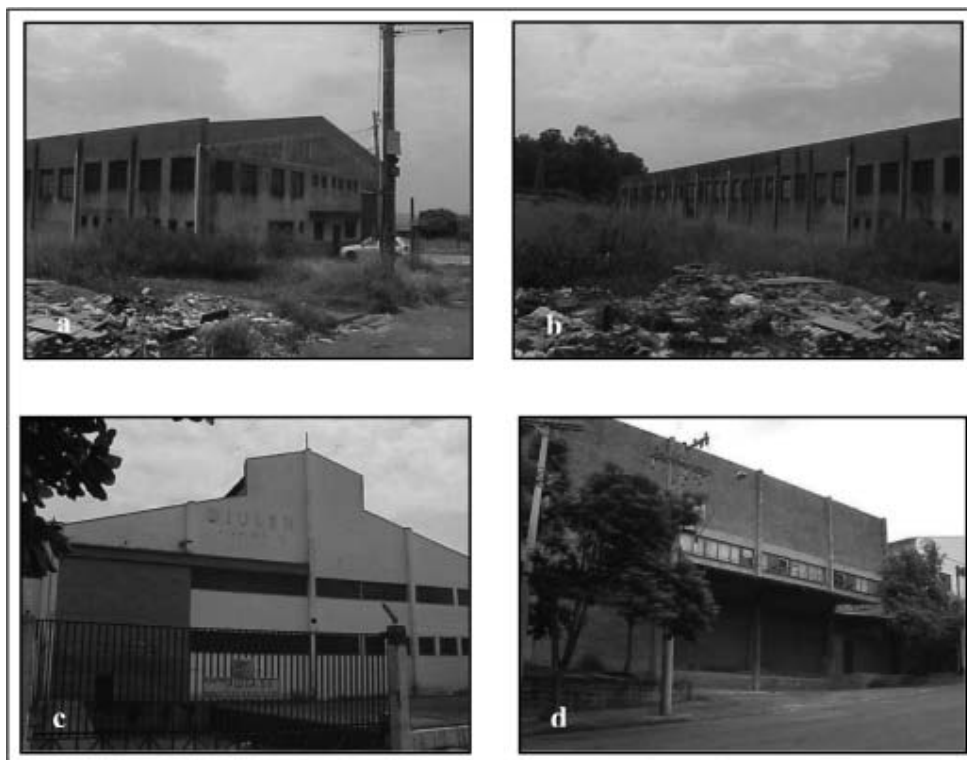
Figura 6 - Exemplos de imóveis abandonados, Jd. São Luiz, Setor 09: imóvel parcialmente abandonado (a); prédio abandonado da antiga Têxtil Giulen (b); Indústria Têxtil LTDA – Setor 09
