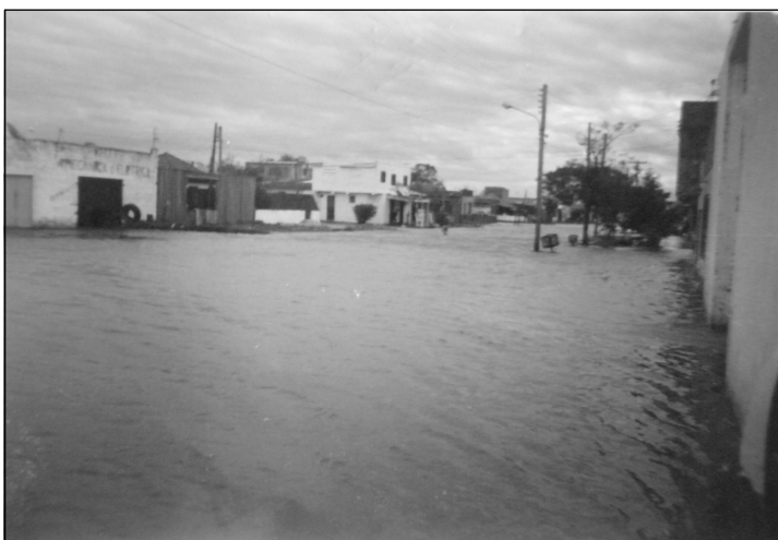
Figura 16 - Vista para oeste na avenida paralela à margem que passa em frente ao Jóquei Clube, durante a inundação de 8 de outubro de 2001
