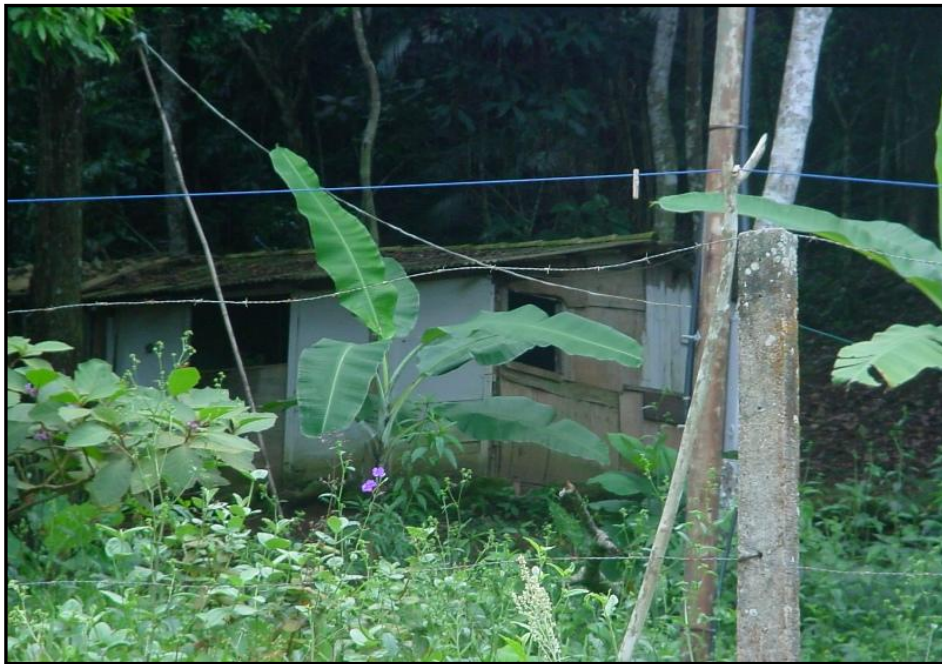
Figura 11: Numa área menos valorizada, as condições da moradia demonstram que, provavelmente, o poder público não chegou lá. O domicílio evidencia fortes carências: como falta de saneamento ambiental adequado e de equipamentos públicos. Ubatuba (SP).
