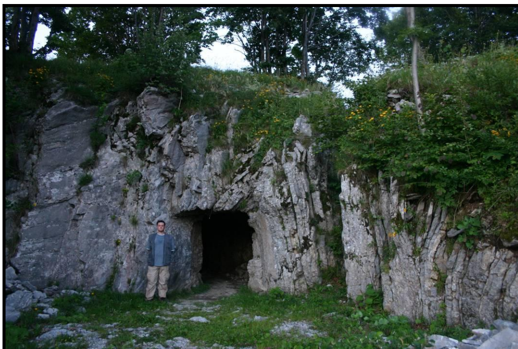
Figura 12: Entrada de uma caverna artificial no Monte Kolovrat. Nota-se a inclinação das camadas e fraturas na rocha. A região apresenta uma série de fortificações como trincheiras, cavernas, postos de comando, postos de observação, posições de metralhadoras e peças de artilharia (Foto: Luiz E.P. Travassos, 2009).
