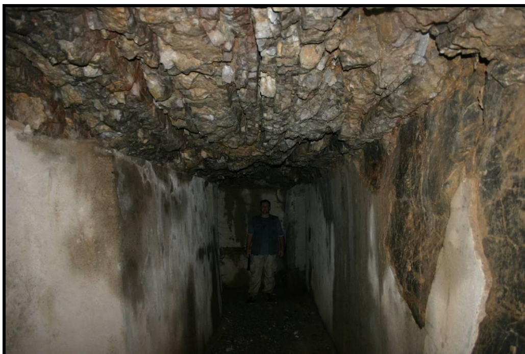
Figura 14: Detalhe dos reforços de concreto no interior de uma caverna artificial no Mt. Kolovrat (Foto: Luiz E.P. Travassos, 2009).
