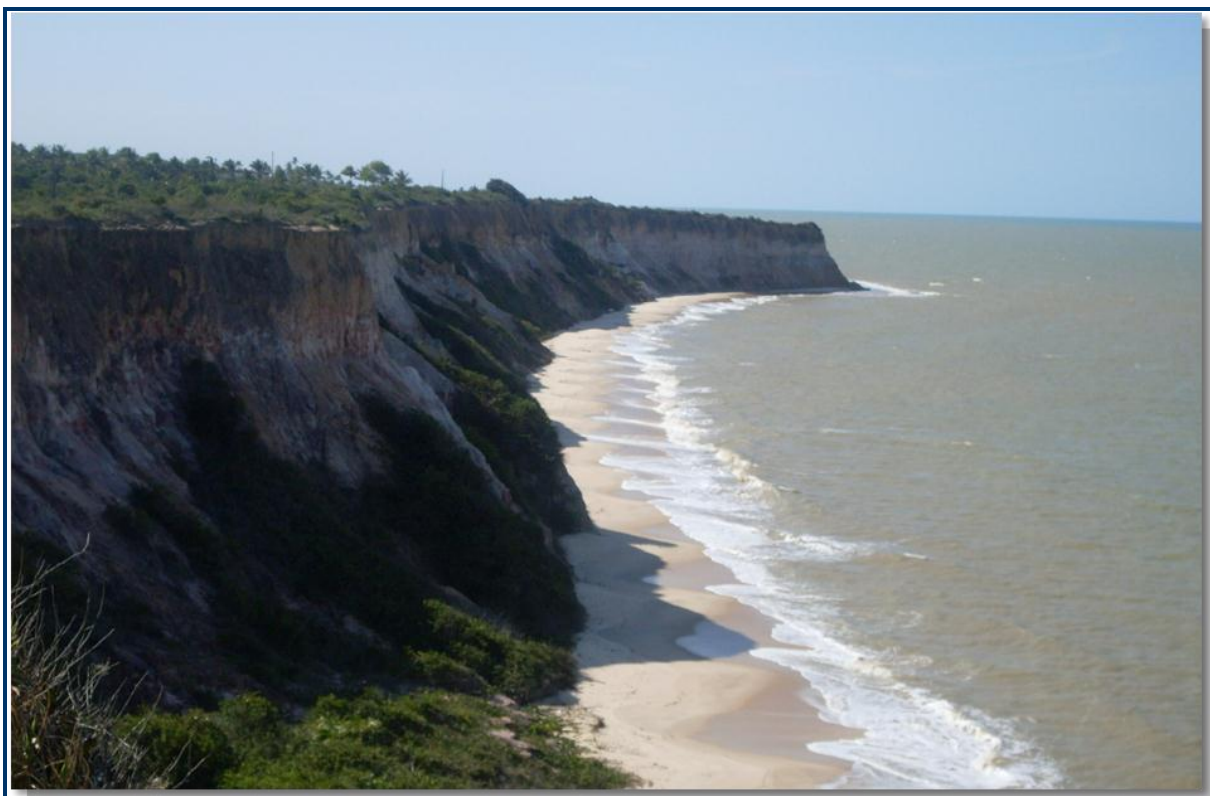
Figura 18: Falésias ativas formadas por sedimentos inconsolidados da Formação Barreiras, município de Prado (BA) nas proximidades da BA 489, Praia da Paixão.
