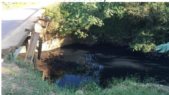
Figura 5 - Trecho do APF junto à rua Adão Foques (Guaíba/RS) (Coordenadas UTM:22s 4673890 6663639S).
