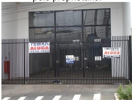
Figura 3. Portão instalado pelo proprietário.
