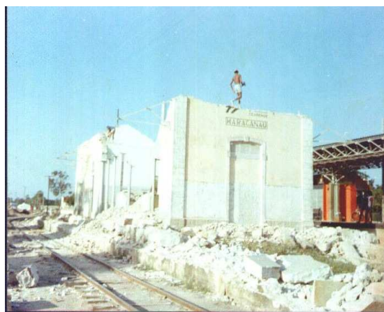
Figura 4 - Demolição da antiga estação ferroviária de Maracanaú (s/d).
