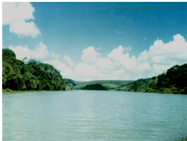
Figura 19 – Vista parcial da Barragem Brejão
