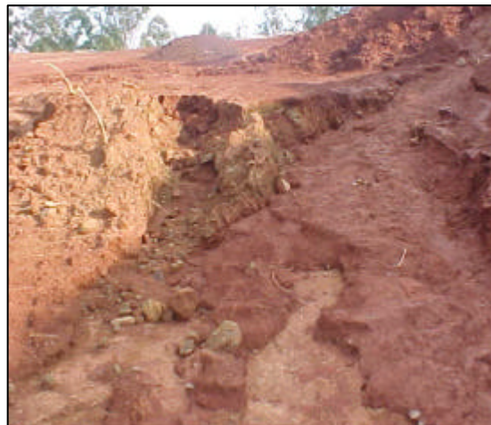
Foto 17. Processos erosivos no alto da cava
