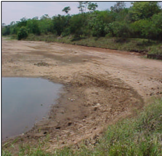
Foto 9. Deposição de sedimentos nas margens do reservatório
