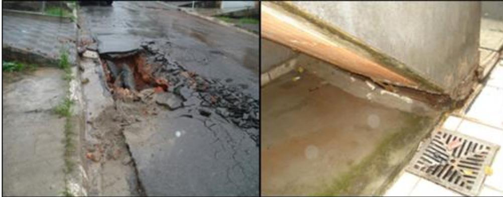
**Figura 8.** Local do rompimento da rede de abastecimento de água e comprometimento de imóvel próximo. Fonte: SAAE Guarulhos.
