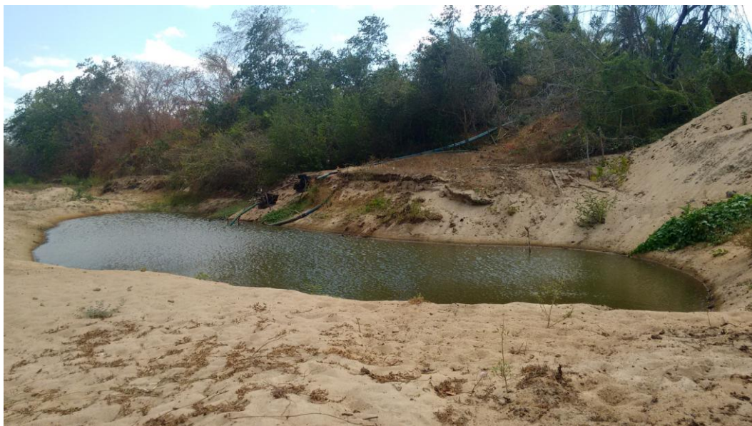
Figura 6. Bombeamento de água na escavação no leito do Rio Curu, Pentecoste- CE
