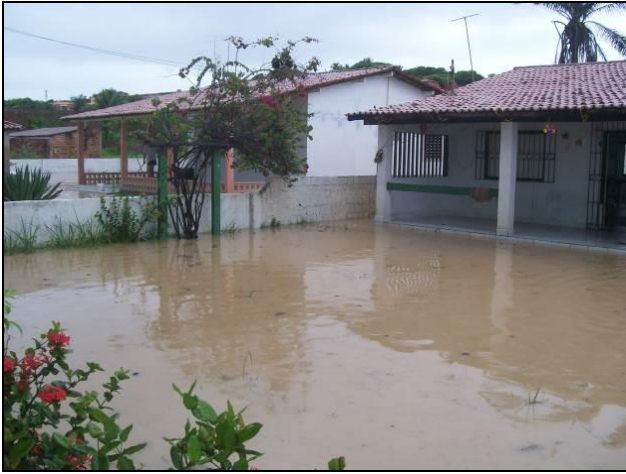
Figura 2. Transbordamento do rio causando inundação em loteamento. Foto: PMCSA, 2008.
