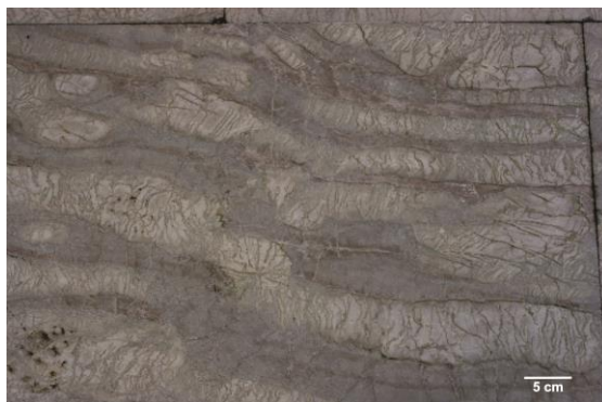
Figura 16. Estromatólitos em cortes longitudinais do piso da escada do edifício da Superintendência Regional da Receita Federal.
