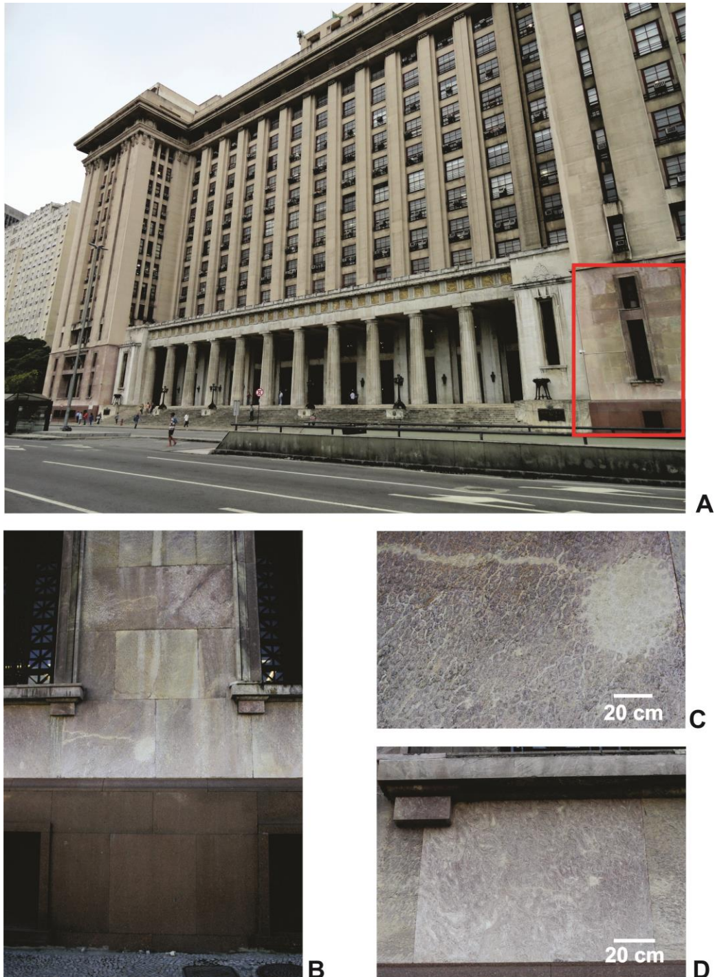
Figura 15. A. Fachada do edifício da Superintendência Regional da Receita Federal. B. Detalhe de parte da fachada. C. Cortes transversais dos estromatólitos desenvolvidos normalmente. D. Os mesmos corpos estromatolíticos deformados em função da adaptação às correntes.
