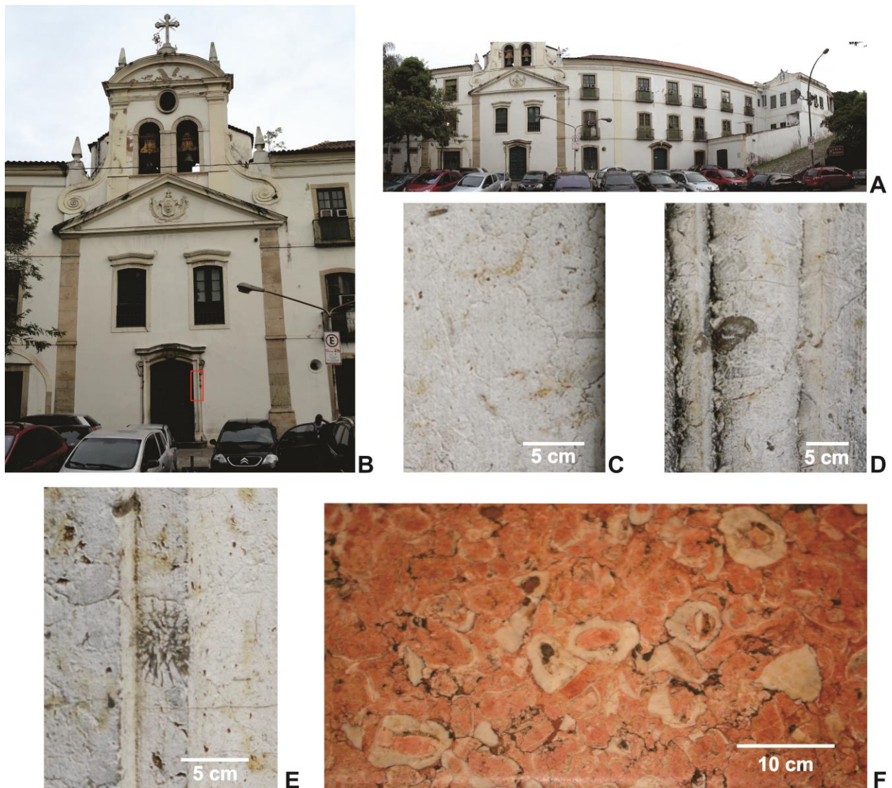
Figura 19. A. Fachada da Igreja Nossa Senhora de Bonsucesso, com parte da ladeira da Misericórdia. B. Detalhe da fachada com Calcário Lioz. C. Bivalve rudista caprinídeos em seção transversal. D e E. Corais solitários em seção transversal. F. Bivalve rudista radiolítídeo em seção transversal.
