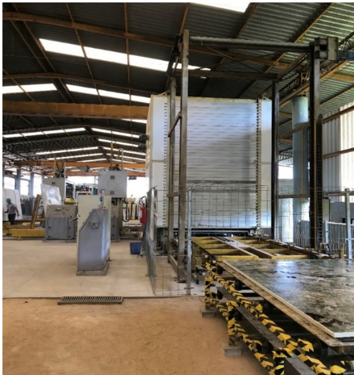
Figura 5 – Vista do forno de catálise da linha automática de resina automática (estrutura metálica em formato vertical).
