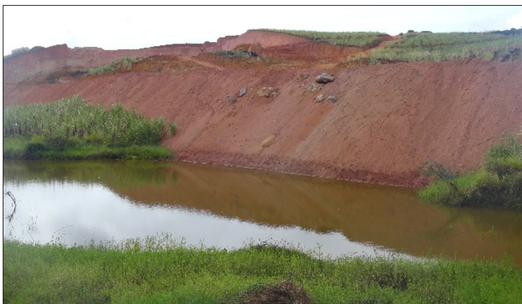
Figura 7 - Riacho Contra-açude com aterro em área de margem para retificação de trecho de seu curso, localizado no bairro de Ponte dos Carvalhos, município do Cabo de Santo Agostinho, Pernambuco (Fonte: CPRH, 2017).
