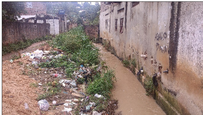
Figura 3 - Riacho Lava-tripás com ocupações urbanas sob suas margens em seu médio curso, localizado no bairro de Águas Compridas, Olinda, Pernambuco.
