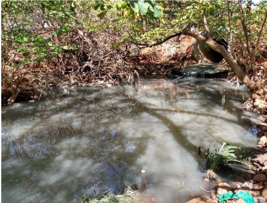
Figura 5 - Lançamento de águas cinzas por meio da galeria pluvial na Lagoa dos Macacos.
