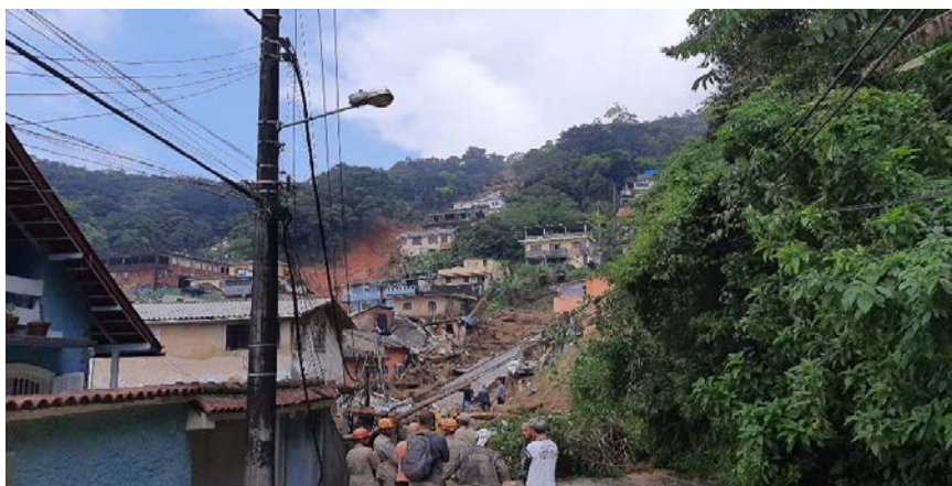
Figura 13 - Imóveis destruídos pelos deslizamentos ocorridos na região da Vila Felipe.
