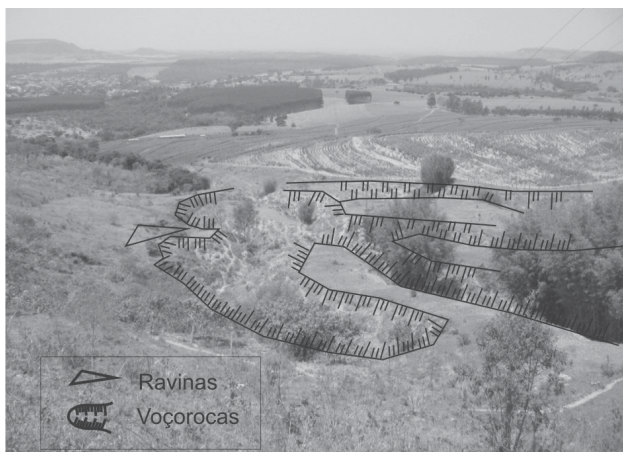
FOTO 3. Voçorocamento existente no setor oeste da bacia do Córrego do Cavalheiro.
