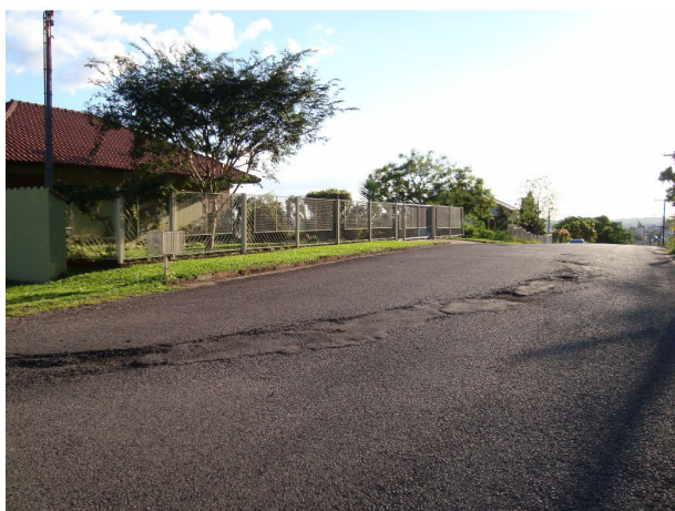
FIGURA 14. Trinca na rua Dr. Álvaro Correa e aspecto de uma moradia com sérios danos.
