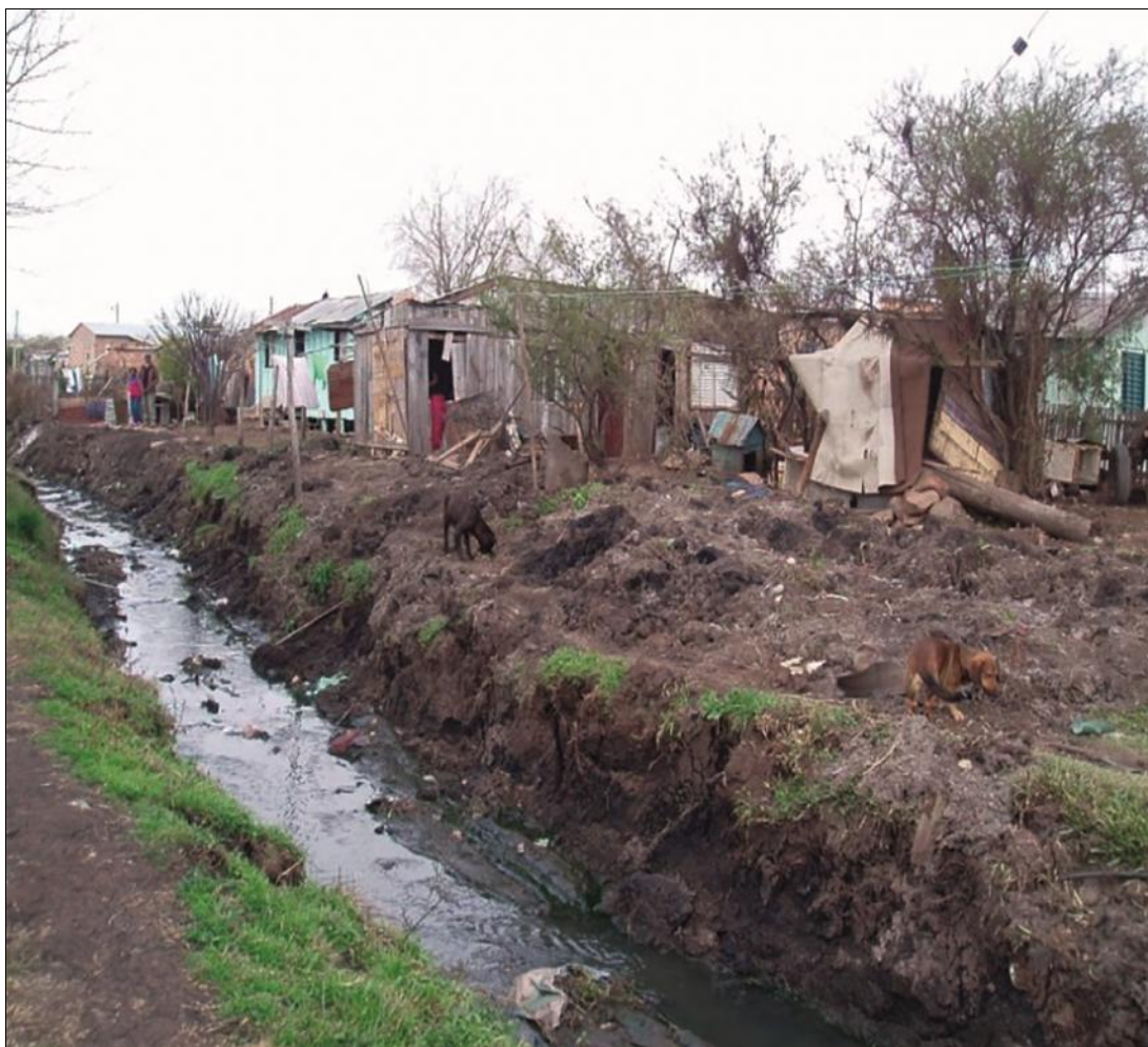
Fotografia 3 – Canal fortemente antropizado associado a processos de inundação brusca e alagamento no bairro Sepé Tiaraju, 2009.
