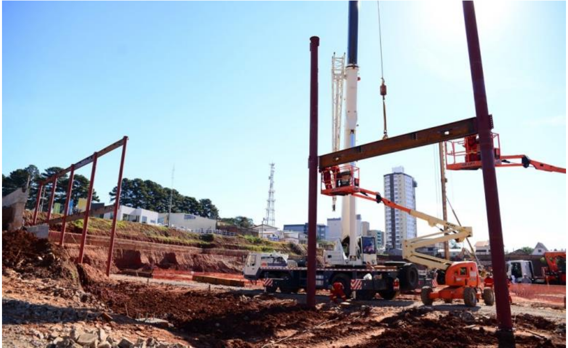
Figura 03: Imagem das obras do Passo Fundo Shopping , fase de instalação da estrutura metálica, em maio de 2016.
