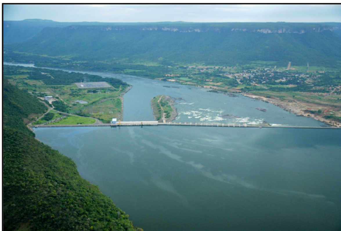
Figura 2 – Vista panorâmica no sentido montante-jusante da UHE Lajeado no rio Tocantins, (da esquerda para direita) margem esquerda o município de Miracema, seguido da casa de máquinas, vertedouros e na margem direita o município de Lajeado. Foto: Kelson Dias Gomes, novembro, 2005.
