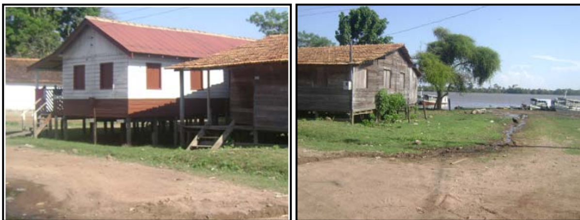
Figuras 3 e 4 - Evidências de moradias em condições de riscos às margens do Surubiú, município de Alenquer (PA). Fotografia: Orleno Marques, 2010.
