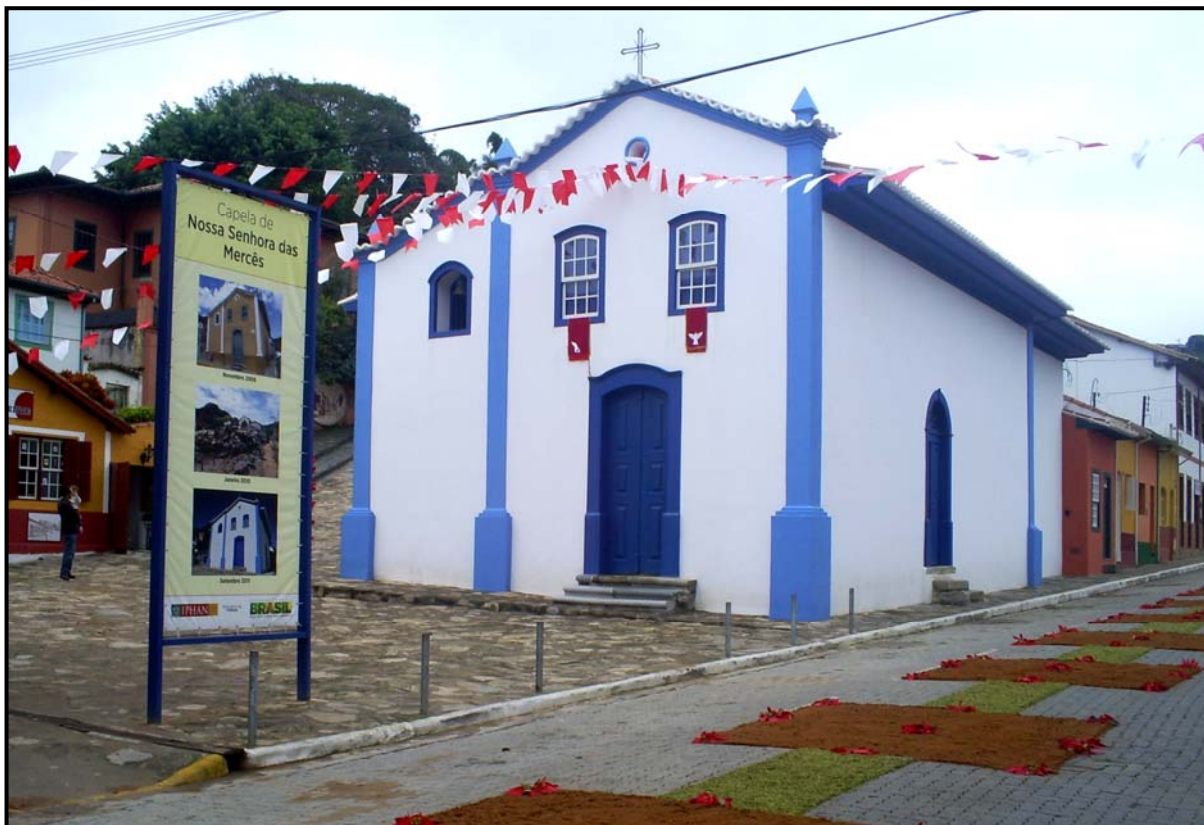
Figura 7 – Capela das Mercês após reconstituição realizada pelo IPHAN.
