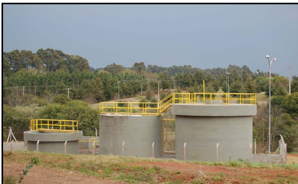
Figura 6 - Estação de Tratamento de Esgotos. Foto: FRANDOLOSO, M. A. L., out./2006.
